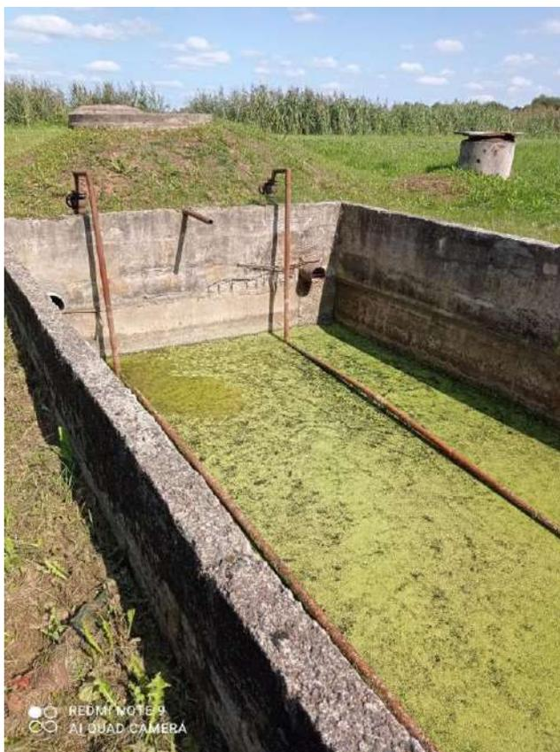
Рисунок 3.5 – Приемный лоток дождевых сточных вод
